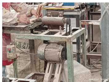
NC No pulley guard.jpg
